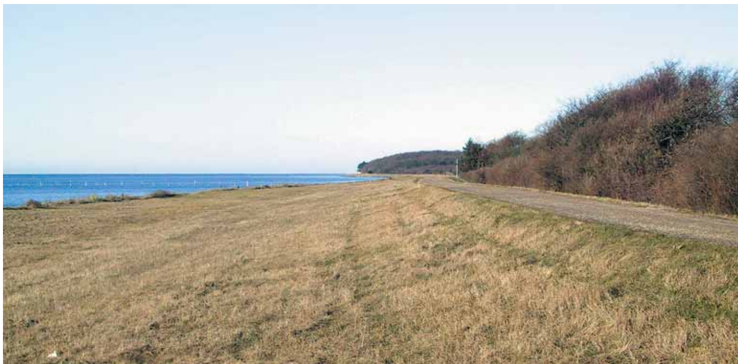
Stormflodsdiget. Det 63 kilometer lange og 4,4 meter høje dige strækker sig langs hele Lollands sydkyst og skærmer det bagvedliggende land fra havet. Med tiden har det også fået en rekreativ funktion med en vandre- og cykelsti på digekronen, der er blevet en del af amtets regionale stinet.
