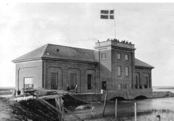
Den gamle pumpestation ved Kramnitse blev taget i brug i 1927 og fungerede frem til 1965.
