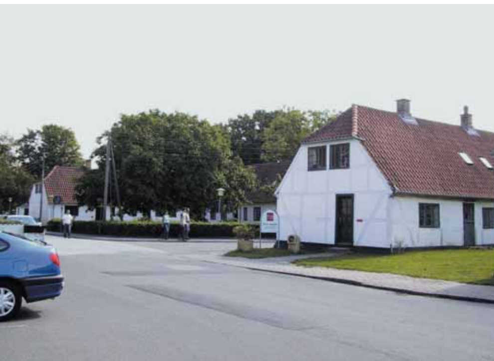
De første arbejderboliger. Fra begyndelsen sørgede Holmegaard for boliger til de ansatte. Længerne i overkalket bindingsværk er de første arbejderboliger på stedet. De tre længer lå ud til Glashytten, og efter fyraften var det almindeligt, at arbejderne mødtes omkring de varme glasovne. Det understregede fællesskabsfølelsen og solidariteten med "Glasværket", som Holmegaard blev kaldt af de ansatte. I dag huser længerne museum og butik.
