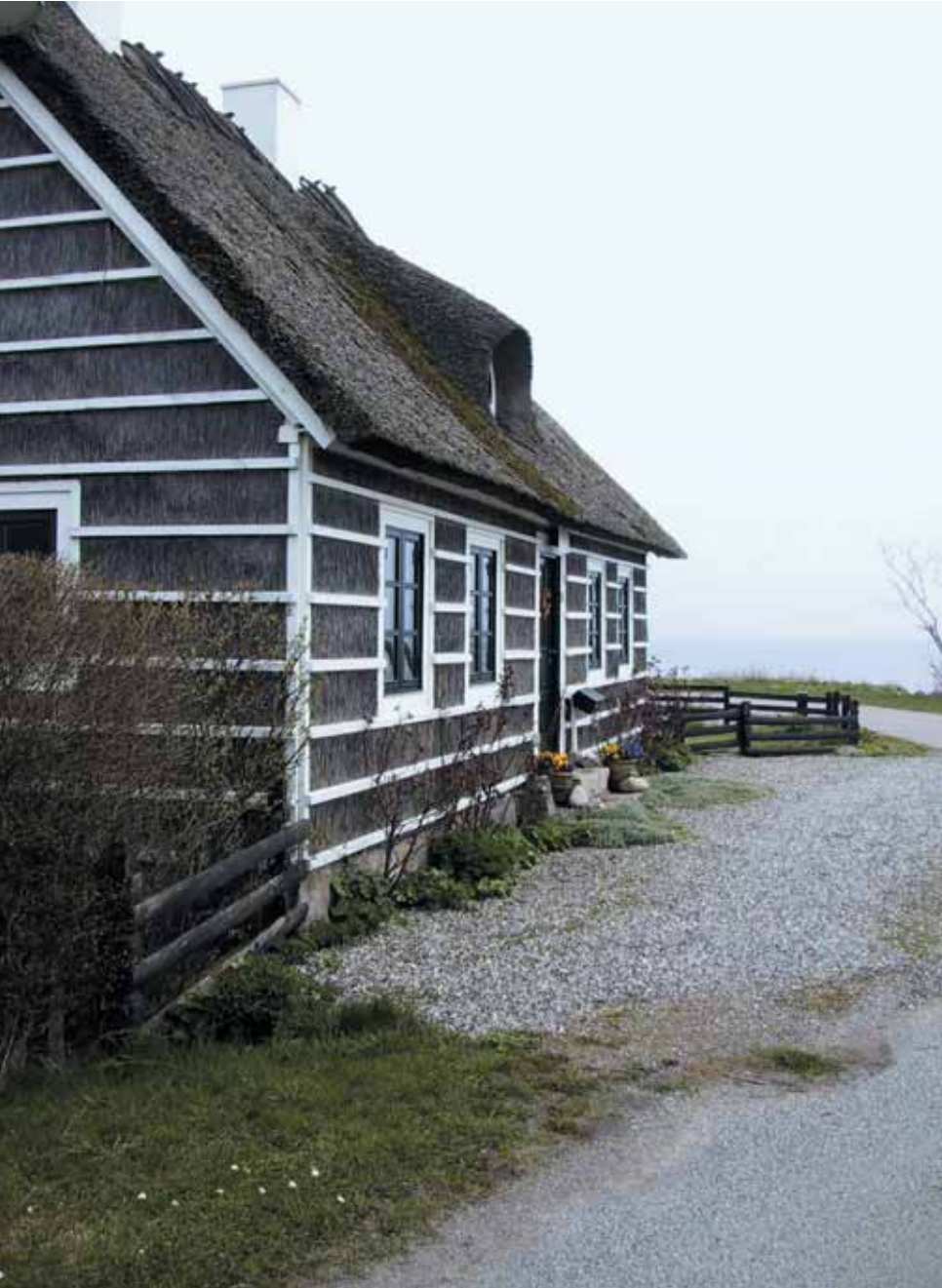
Strå og skaberatter. Hesnæshusenes stråbeklædning, fastholdt af malede lægter, har i dag vital betydning for stedets identitet. Det samme har de udskårne vinduesindfatninger, kaldet "skaberatter". Traditionen kan følges tilbage til Gotfred Tvedes tid og har ikke rod i en tidligere byggeskik på egnen.
