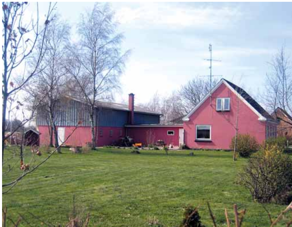
Tag og trempel. Det er ikke alle stuehusene ved Berritsgård, der har afvalmet tag. En del har saddeltag, der afsluttes med en murkrone. På billedet ser man tydeligt staldbygningens trempel, som er den træbeklædning, der går fra den øverste del af facaden og op til taget. Såfremt området skal beholde sit enhedspræg og særlige udtryk, er det vigtigt, at man holder sig sådanne karakteristika for øje. Men også detaljer som vinduer er vigtige for bygningens helhedsindtryk. Således påvirker valget af termoruder i stedet for de oprindelige vinduesrammer bygningens fremtoning.
