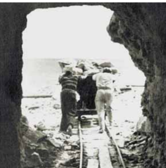
Fortet bygges 1951-54. Stevnsfortets underjordiske gange er hugget ind i kalkklienten, 18 meter under jordens overflade.
