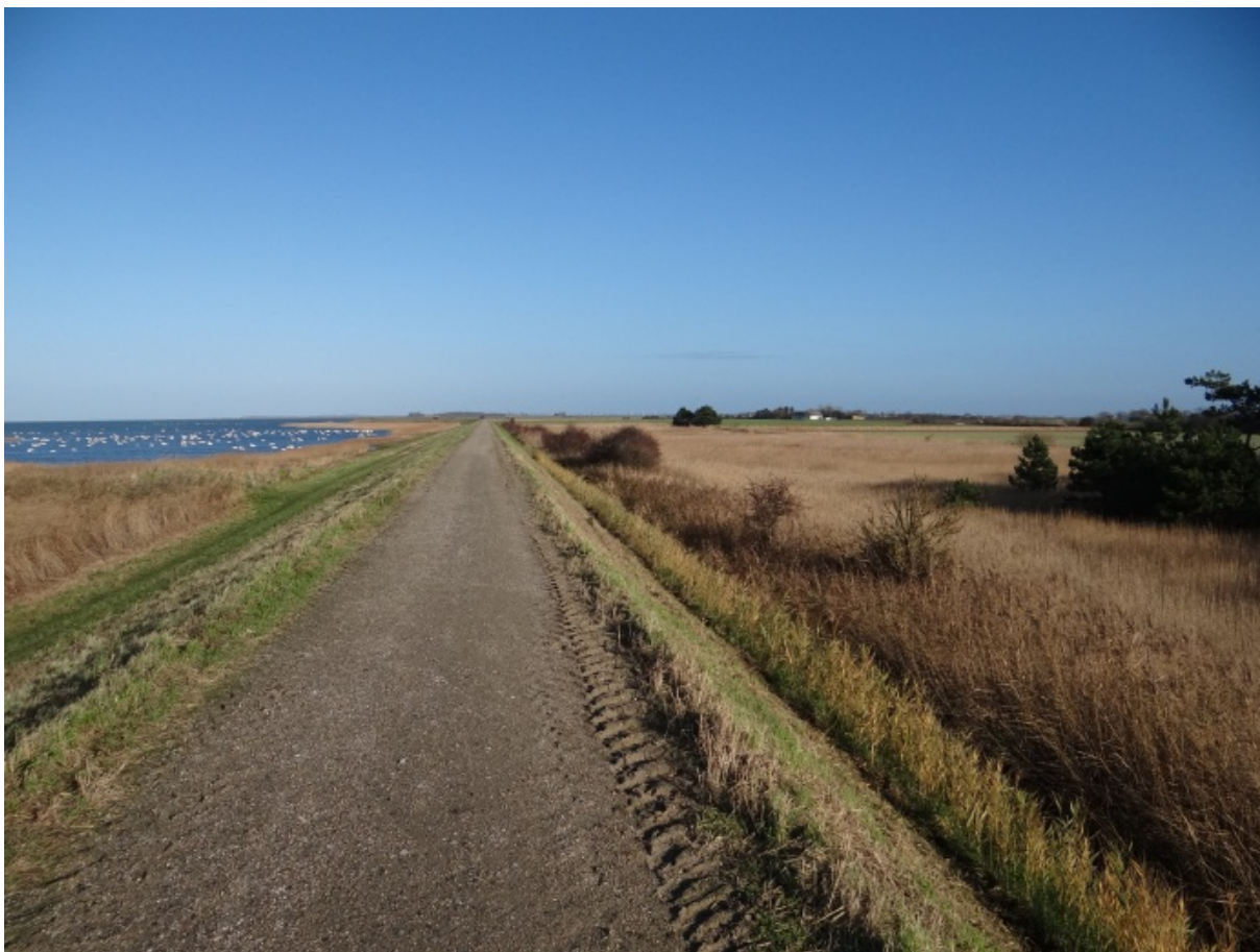
Foto 42. Det lollandske Dige udgør et særligt kendetegn for området.
